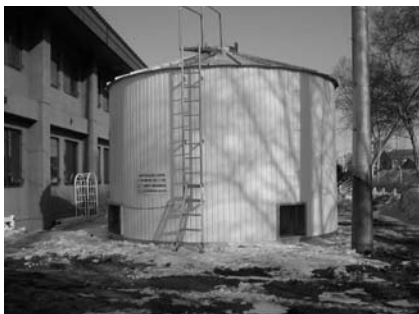
帯広の冷房施設 (モナリスクアイスシェルター) 冷房面積204m 2 貯水量48トン 2000年完成
