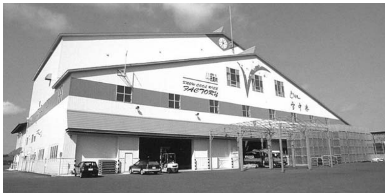
沼田町の米低温貯蔵施設(雪中米) 1995年建設、貯雪量1,500トン、米処理量8,000トン
