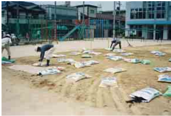
土壤改良資材を均等に配布し、開封する。
