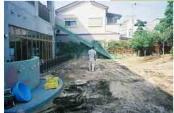
土壤改良資材を敷き均した後、 耕耘機で土と混合する。
