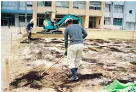
散布した資材をトンボで敷均す。
