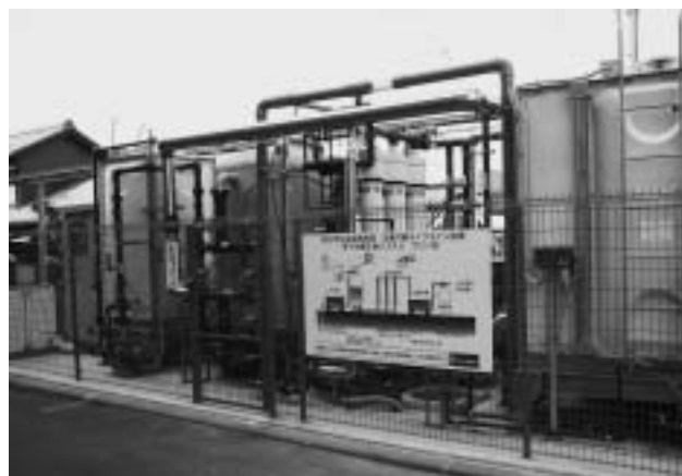
三重県四日市市の四日市社会保険病院に導入された地下水膜ろ過システム。NHKにも取り上げられたプラントで、衛生監視システムも設置されている。
